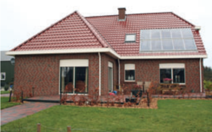
De 13 m 2 grote zonnecollector op het dak van de woning.
