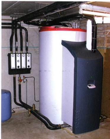
Zonneboiler met geïntegreerde HR-gasbrander en een inhoud van 750 liter (SolvisMaxGas).
